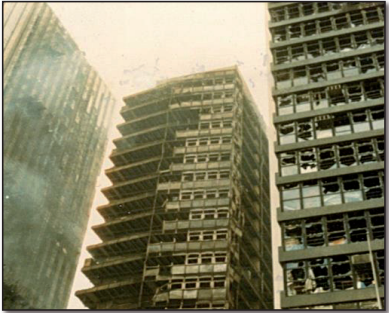
Figura 6: Propagação entre blocos.
